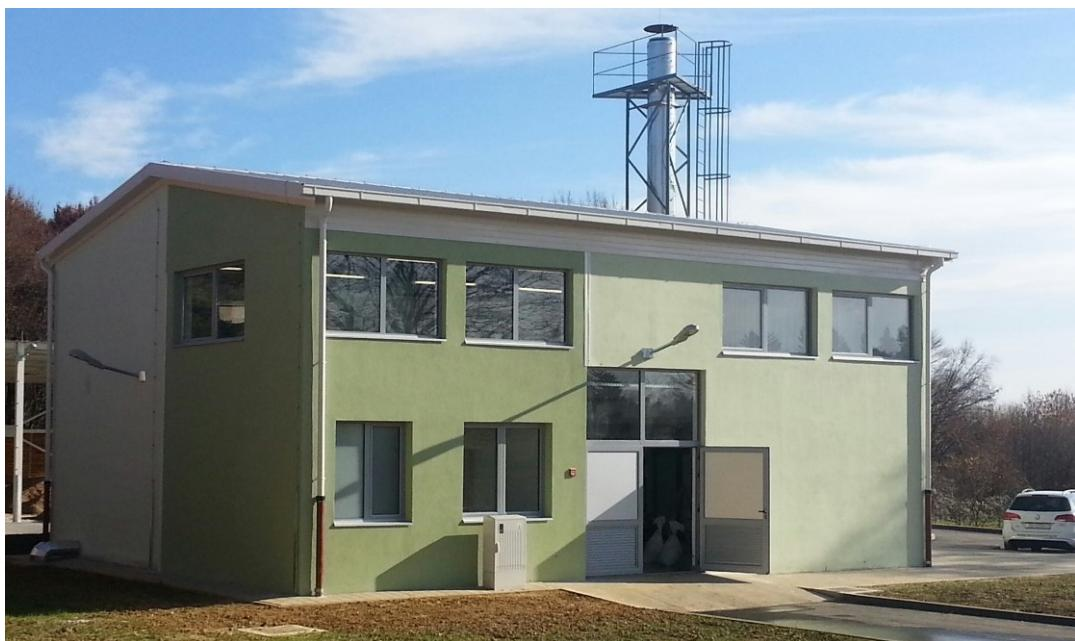
Toplovodna kotlovnica se loži drvnom biomasom toplinskog kapaciteta 1.000 kW na parceli broj 8/1, K.o. Pokupsko. Pored toplovodne kotlovnice je smješten spremnik biomase dostatan za dva mjeseca rada. Na krovu nadstrešnice su instalirani solarni kolektori koji služe za zagrijavanje potrošne tople vode (PTV-a) potrošača priključenih na mrežu CTS-a i dogrijavanje polazne vode u mreži CTS-a.
